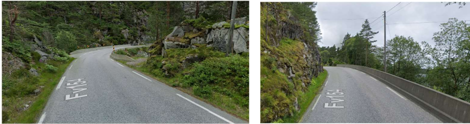
Figur 13 Tømmervika – dårlig kurvatur begrenser sikten. Kilde: Google Street View
