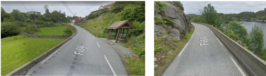
Figur 5 Lavt betongrekkverk, veglys og busstopp høyt betongrekkverk. Kilde: Google Street View
