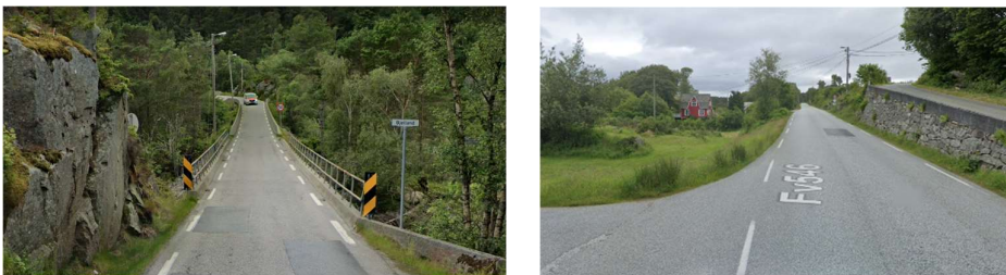
Figur 6 Smal veg (3-4m) ved brua ved Bjelland. Kilde: Google Street View
